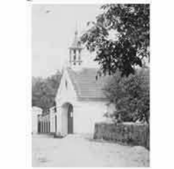
Fotografie původní budovy staré hasičské zbrojnice, avšak fotografie z léta, kolem let 1900 - 1912. Zdroj: archiv Jana Čížka, Jíloviště
