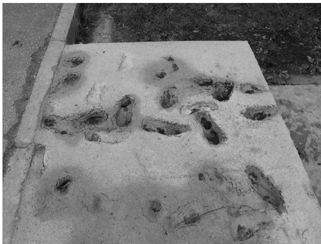
poškození základových desek zastávek, foto Jan Vorel
