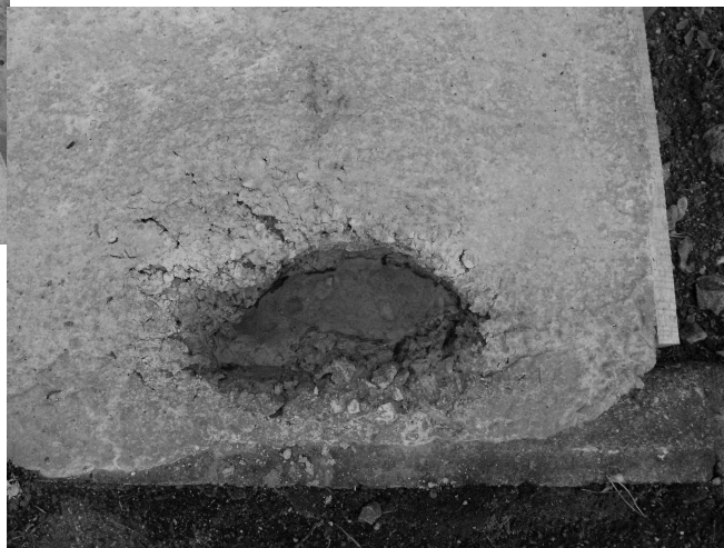
poškození základových desek zastávek, foto Jan Vorel
