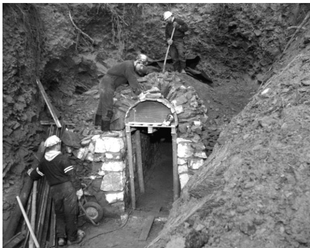
Montánní společnost zajišťovala zpřístupnění tzv. Nové halířské štolý v Jílovém u Prahy. Regionální muzeum Jílové zde bude zřizovat další prohlídkovou trasu zlatorudného dolování.
