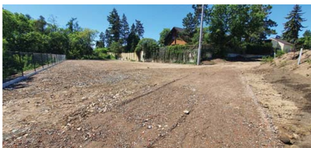
Na fotkách vidíte plochu samotného sportoviště a budoucí parkoviště
