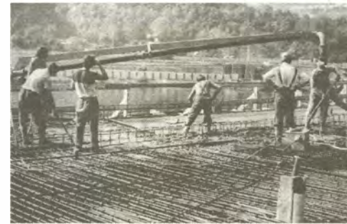
Na výstavbě mostu se podílela skupina polských tesařů.
