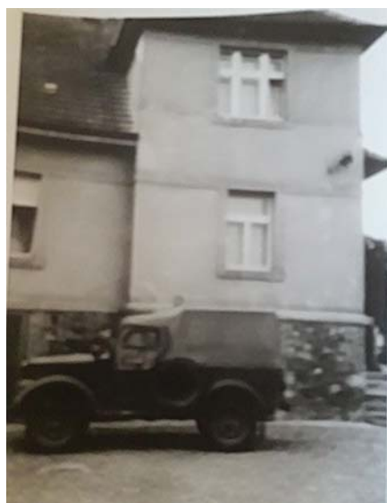
Foto z roku 1975 - pohled na dům ze dvora
